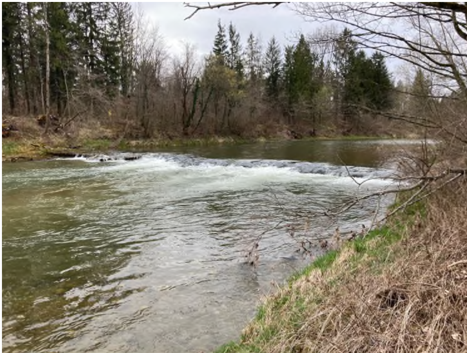
Abbildung 2: Ein Querbauwerk in der Alz nahe der Trostber- ger Kläranlage er- schwert gerade schwimmschwachen Fischen das Weiterkom- men im Fluss. Foto: Wasserwirt- schaftsamt Traunstein
