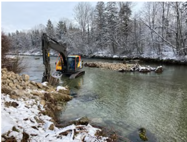
Abbildung 1: Ein Bagger nimmt mit seiner Schaufel angelieferte Wasserbausteine auf und legt mit ihnen eine kleine Insel inmitten der Alz an. Das Foto entstand auf Höhe Mussenmühle. Foto: Wasserwirtschaftsamt Traunstein
